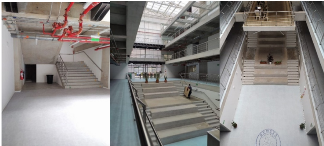
Figura 6. Instalaciones al interior del bloque de aulas MUSD- CESMAG
